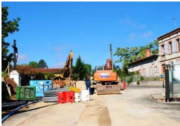
Travaux de réalisation des réseaux pour raccordement du hameau du Terme à l'assainissement collectif
