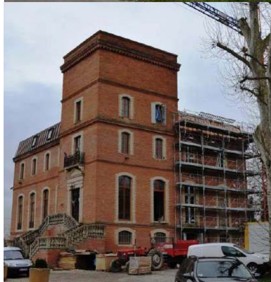
Extérieurs du château de la Garrigue en cours de réhabilitation
