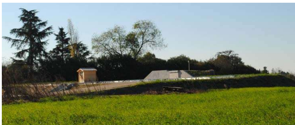
Station d'épuration du Terme achevée et mise en service le 13 janvier 2014
