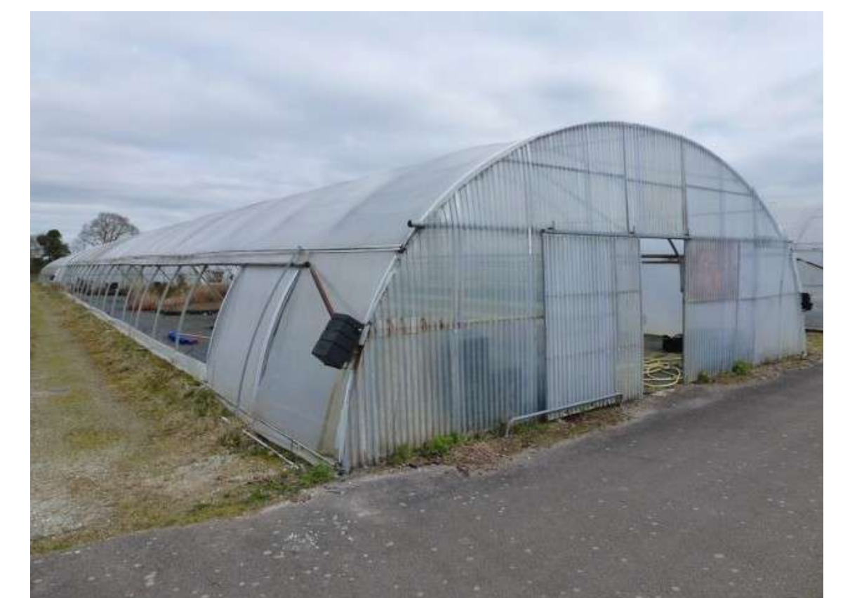
Les serres tunnels (parois en film plastique) ou toutes serres à structure démontable
