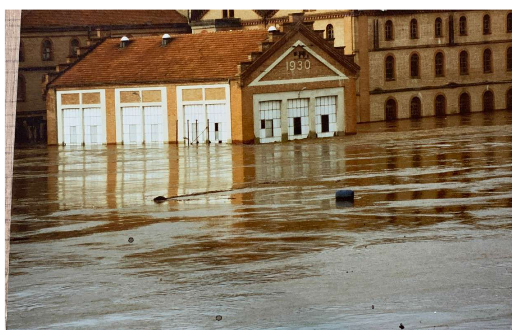
Les bâtiments Brusson en rive gauche
