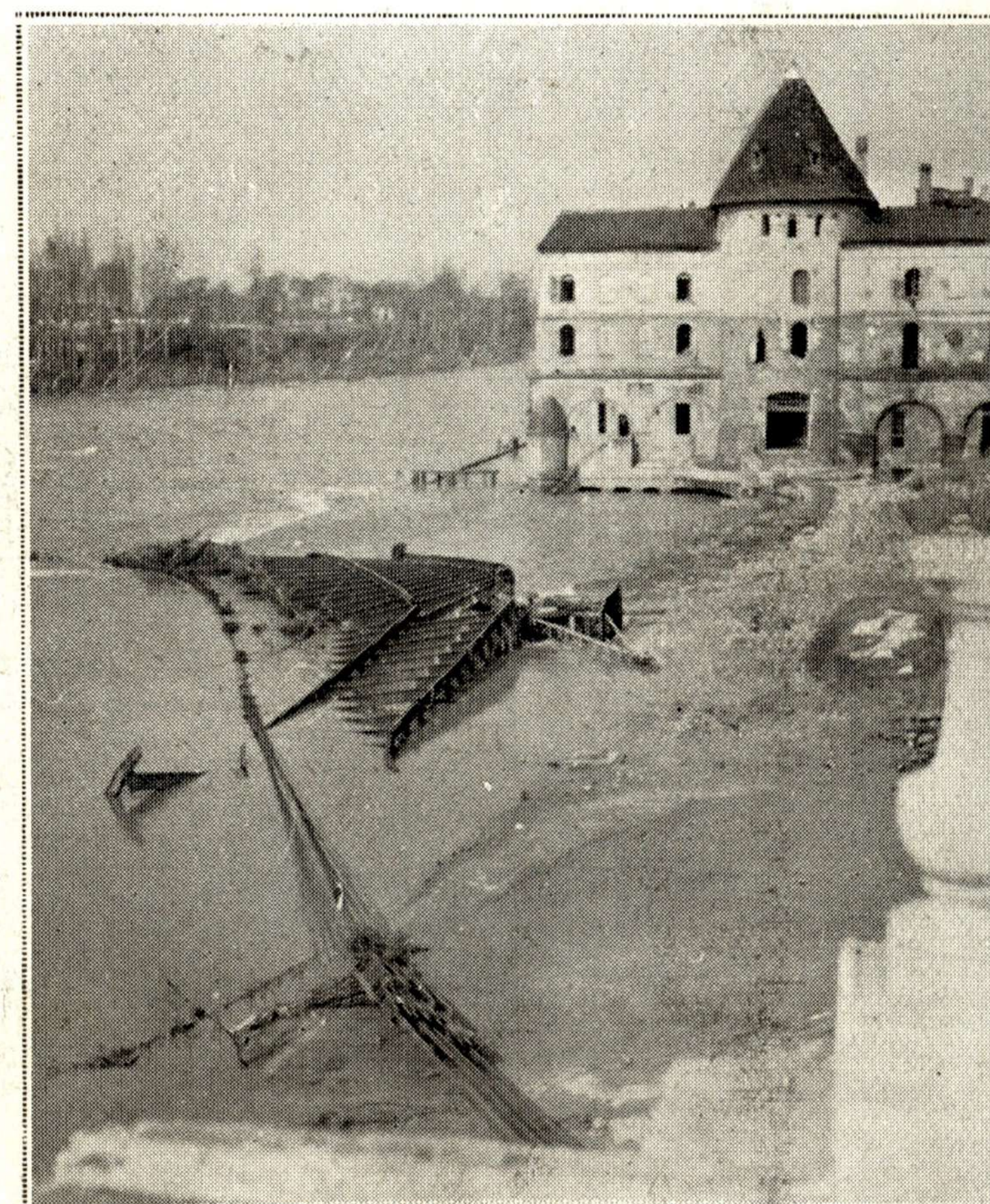
Le pont suspendu de Villemur complètement emporté. On voit, sur les bâtiments, les traces qui marquent, au second étage, la hauteur atteinte par les eaux.
