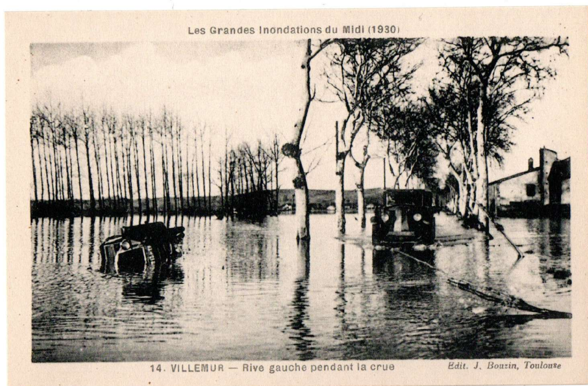
Rive gauche pendant la crue
