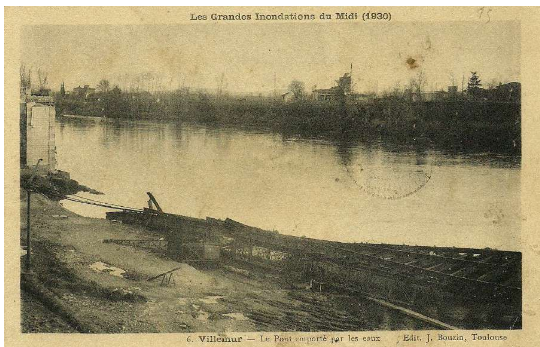
Le pont emporté par les eaux
